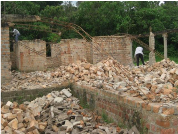
Abriss der alten Krankenstation
