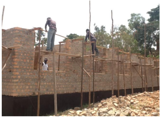
Aufbau der Außenmauern der Krankenstation
