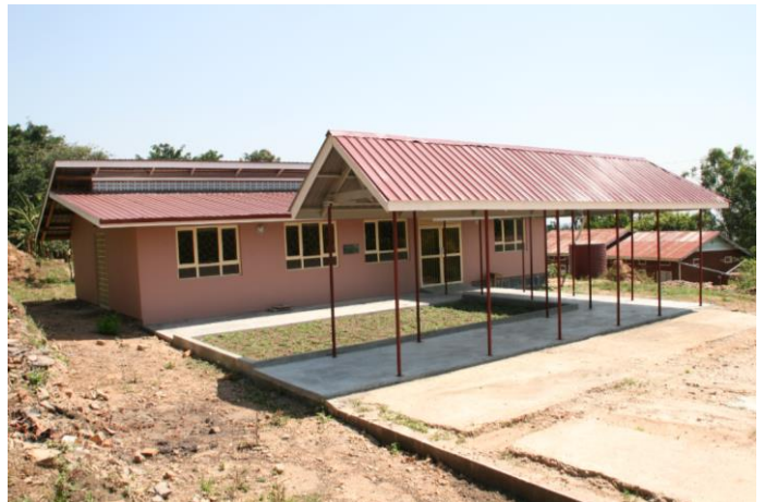
Fertige Krankenstation im Januar 2015
