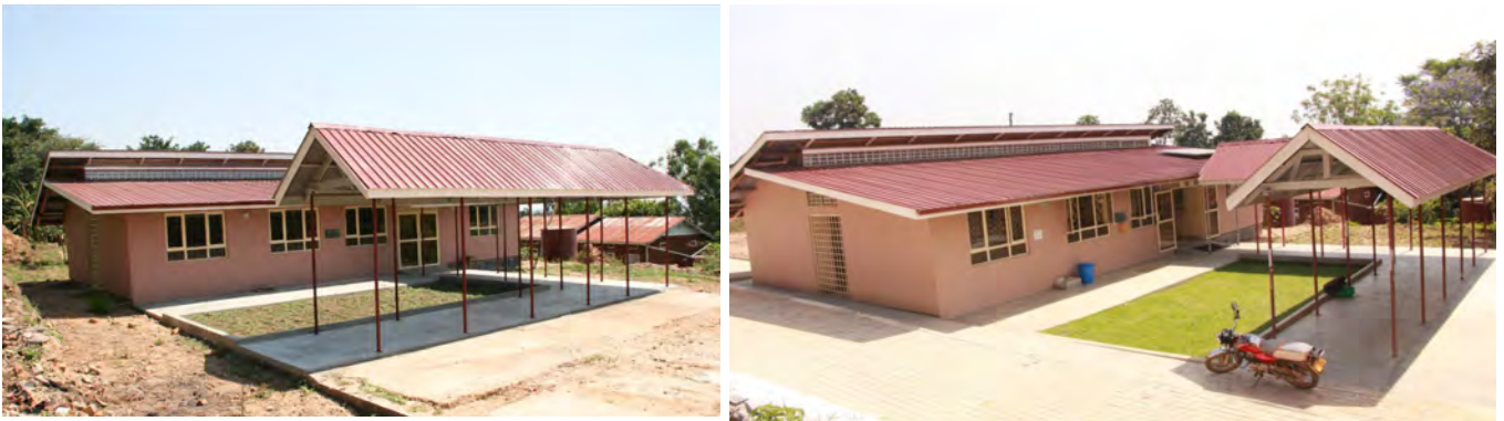
1. Bauabschnitt – Tagesklinik ambulant
